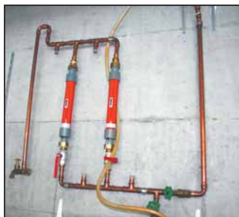
Ces deux tubes d'un appareil Aqua 4D éliminent les dépôts corrosifs à l'intérieur des tuyaux d'eau. LE NOUVELLISTE
